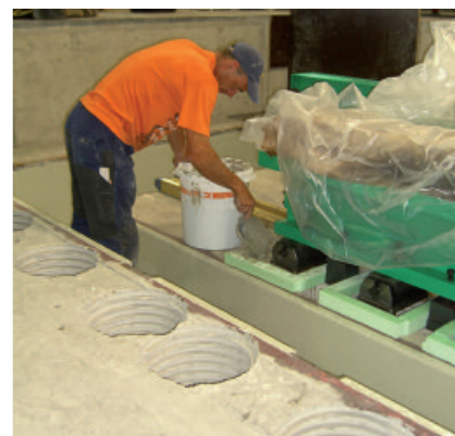
Aangieten van een machineverankering met PCI Repaflow Plus
