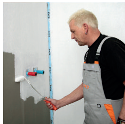
PCI Lastogum wordt onverdund door rollen, kwasten of spachtelen op de ondergrond aangebracht.
