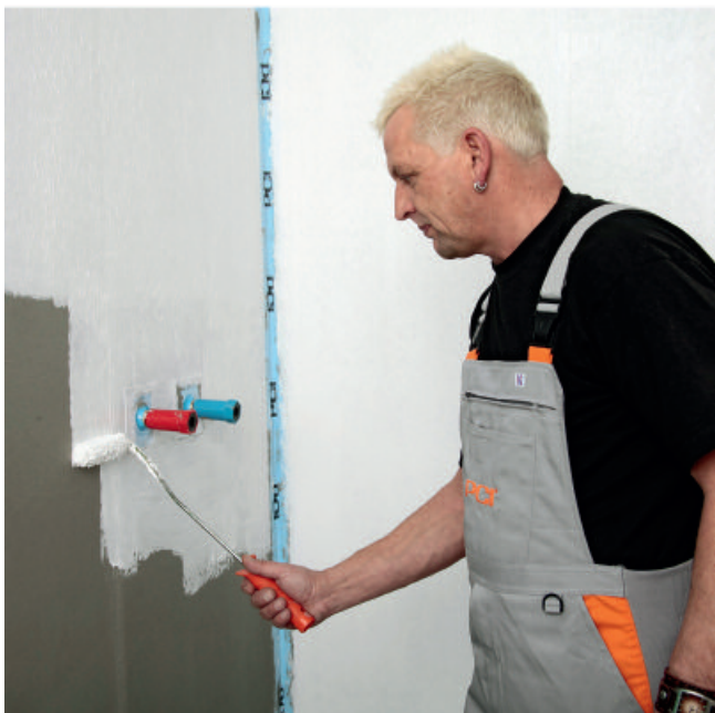
5. Tweede afdichtingslaag PCI LASTOGUM (wit) na een droogtijd van ca. 1 uur aanbrengen. De eerste grijze laag mag niet doorschijnen, zo nodig nogmaals aanbrengen.
